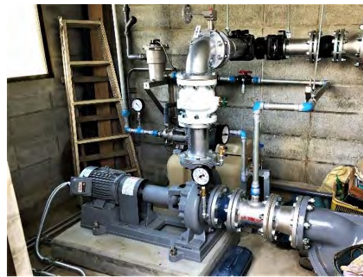
【老朽化した取水ポンプの更新】（泉区）
